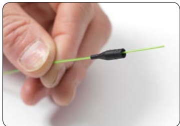
8. Sæt kabeltyllen på fiberen.
