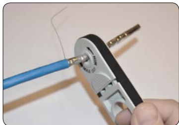
3. Afisoler folien 20 mm. fra kabelkappen. Drej værktøjet i min. retning (hvis max. vælges skades lederne)
