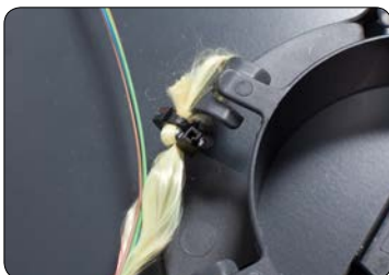
2. Fiberkablet trækafastes ved at kablets kevlar snoes om en fiberholder og låses med en strip. Fiberen konnekteres.
