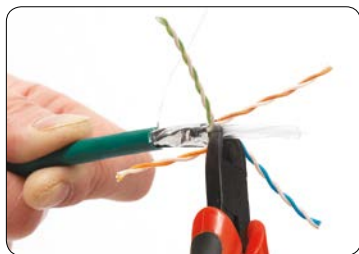
5. Afklip plastkrydset i midten
