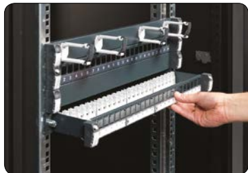
13. Patchpanelet kan nu skubbes på plads igen.
